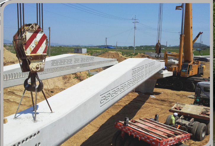
Erection of Edge girder
